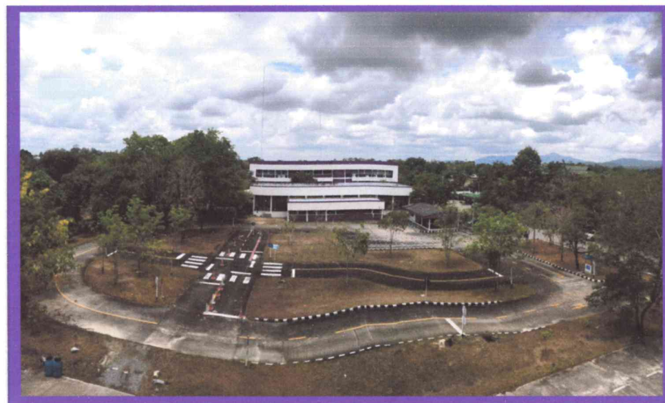
พื้นที่สนามทดสอบขับรถคั้บแคบ ถนนส่วนใหญ่เป็นทางโค้ง ช่วงทางตรงมีระยะสั้น ไม่รองรับการจัดทำสนามทดสอบขับรถด้วยระบบอิเล็กทรอนิกส์ (e - driving)
