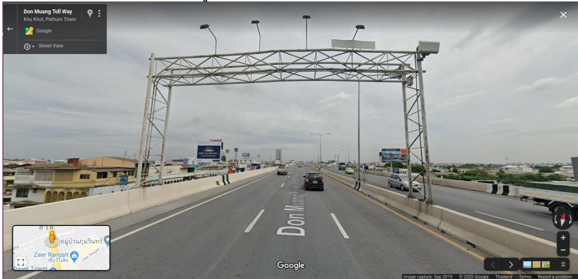
รูปที่ ๓ โครงสร้างของเสาที่มีอยู่แล้วของกรมทางหลวง
